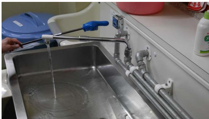
延長棒による水道蛇口の開閉装置
